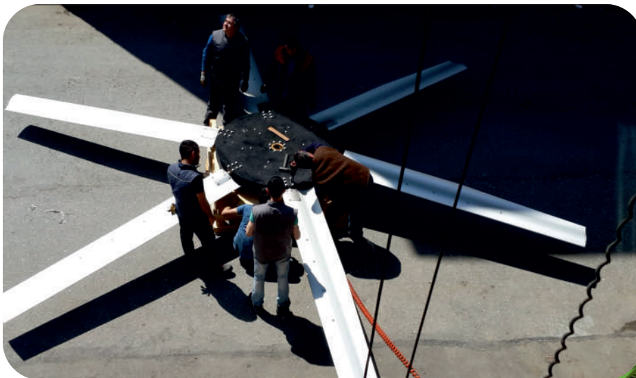
Ventilatori za rashladne tornjeve
